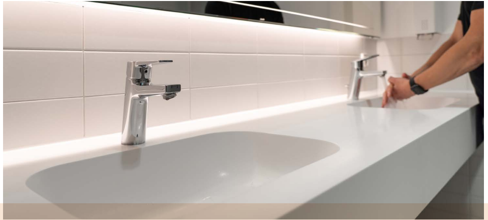
Das SKZ verfügt über eine langjährige Erfahrung in der Prüfung von Armaturen – das Foto zeigt einen Einhebelmischer nach EN 817. (Foto: Luca Hoffmannbeck, SKZ)
