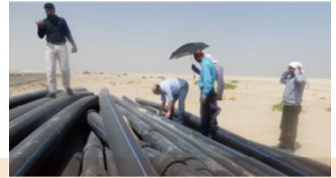
Probeentnahme in Abu Dhabi: Das SKZ prüft seit mehr als 50 Jahren den Zustand von Rohren. (Foto: Ulli Eisenhut, SKZ)
